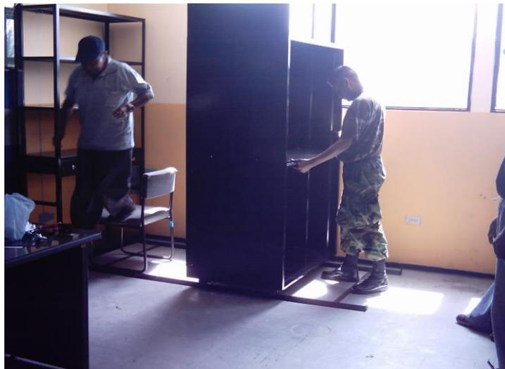
Fig.3.15.- Deslizamiento de los módulos sobre el riel.
