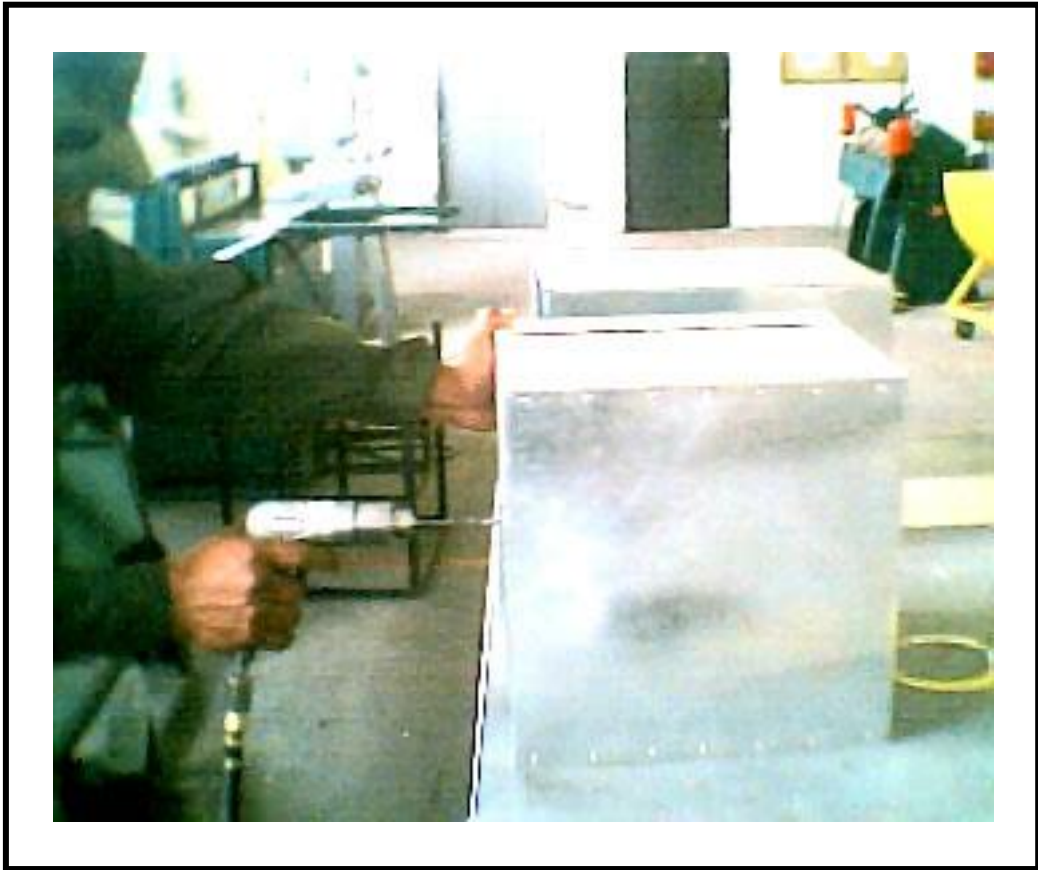
Figura 3.2 . Construcción de los tanques.
