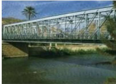
Fig. 1.53. Triangulación de un puente (www.ConstruAprende.com)
