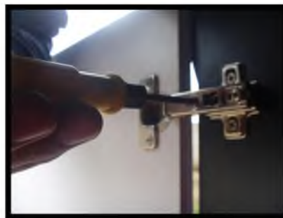
Figura 3.4 Instalación de compuertas y bisagras Fuente: Investigador
