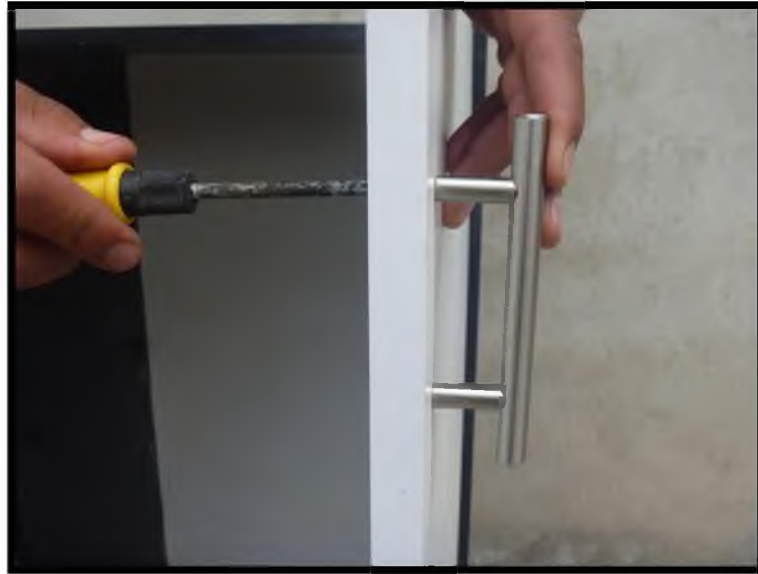
Figura 3.7 Instalación de manijas Fuente Investigador
