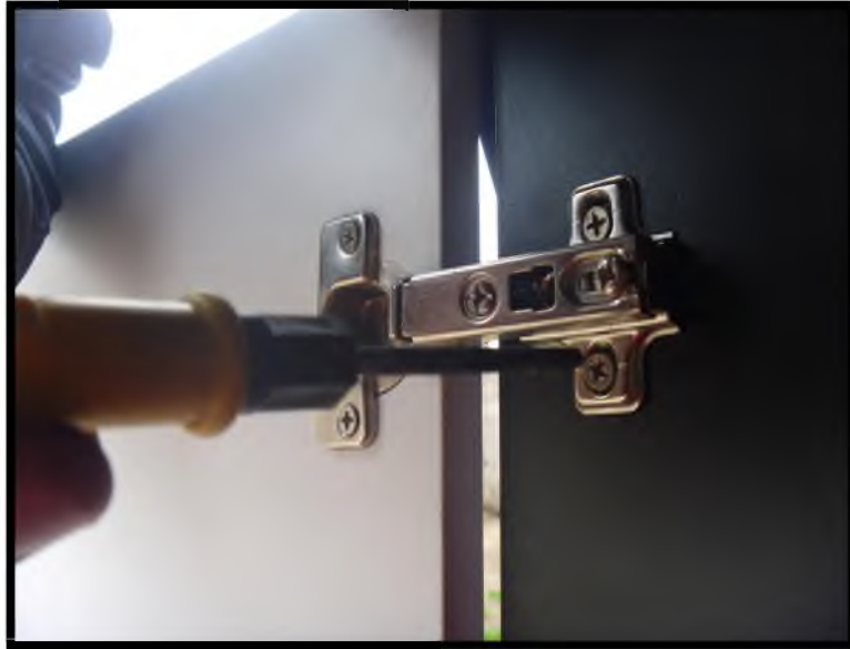
Figura 3.5 Instalación de pernos en las bisagras y compuertas Fuente: Investigador
