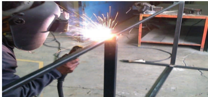
Figura 3. 8. suelda tubo horizontal de apoyo
