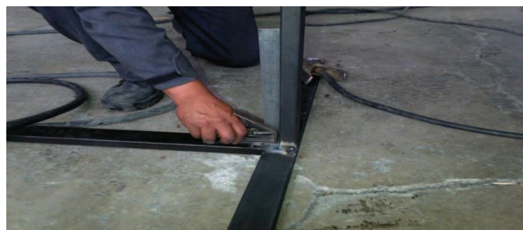
Figura 3. 7. medida del ángulo recto del tubo vertical.
