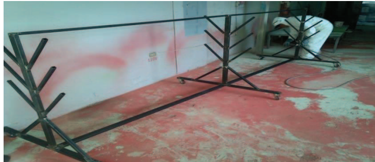
Figura 3. 12. proceso de pintura
