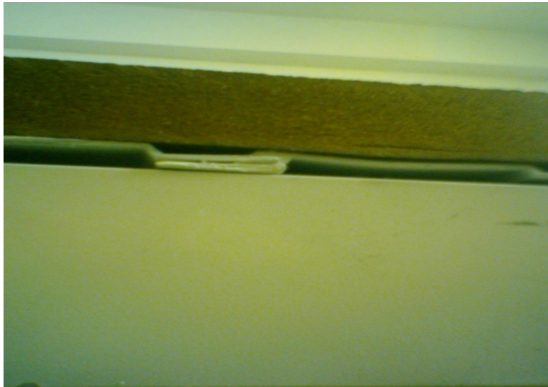
Figura 3.9 Instalación del suelo superficial a la estructura principal. Fuente: Investigación de Campo.
