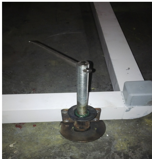
Figura 3.12 Instalación de soportes reguladores. Fuente: Investigación de Campo
