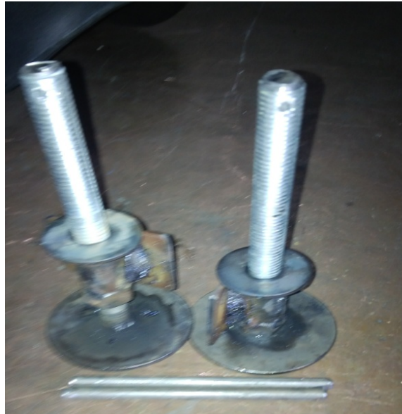
Figura 3.11 Corte y soldadura de tubo estructural y platina. Fuente: Investigación de Campo
