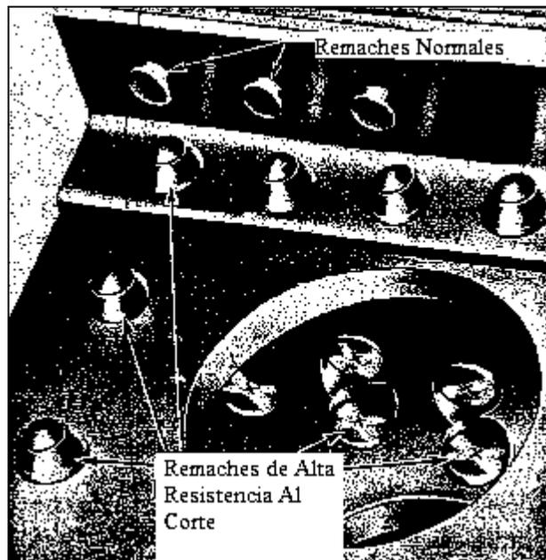
**Figura 1.11. Diferencia Entre Remaches Normales Y Remaches de Alta Resistencia al Corte**
