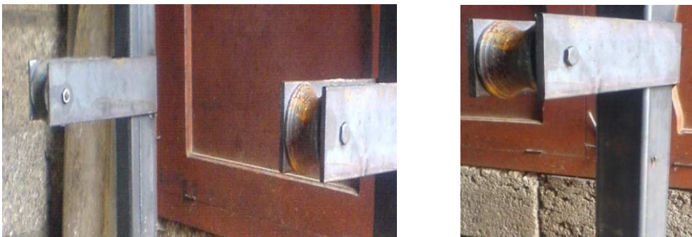
Figura 3.12 Platinas soldadas a los tubos cuadrados
