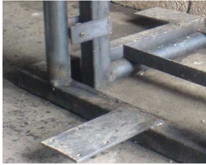
Figura 3.8 Platinas soldadas
