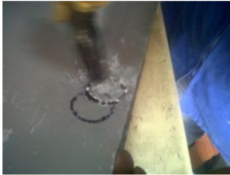
Figura 3.88: Perforación de orificios
