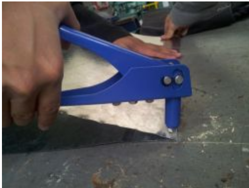
Figura 3.11: Remachado del perfil
