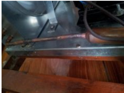
Figura 3.46: Filtro conectado a la salida del condensador
