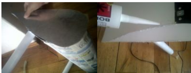
Figura 3.19: Colocación de tapas al perfil
