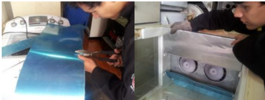
Figura 3.68: Elaboración y colocación de láminas de acero
