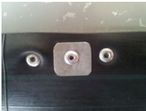
Figura 3.16: Soporte remachado en el perfil
