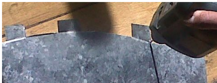
Figura 3.6: Taladro de orificios de alivio entre la costilla y las pestañas
