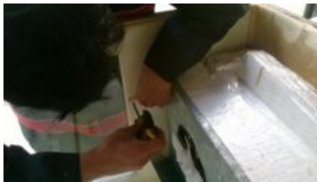
Figura 3.66: Colocación de soportes para vidrios internos
