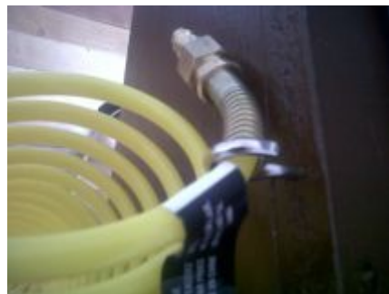
Figura 3.96: Gancho sosteniendo la manguera retráctil.
