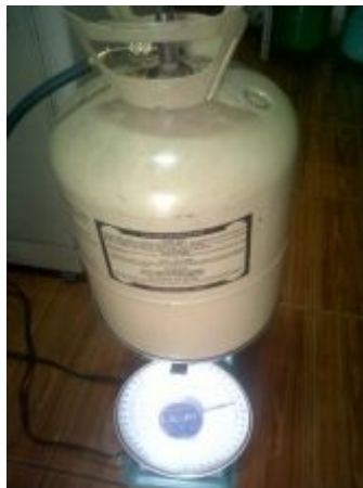
Figura 3.57: Medición de líquido refrigerante ingresado
