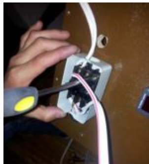
Figura 3.78: Ajuste de cables en paralelo
