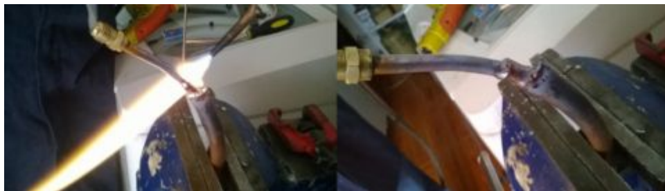
Figura 3.24: Suelda de tubos
