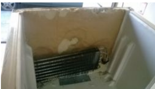
Figura 3.42: Difusor en el interior de la cámara
