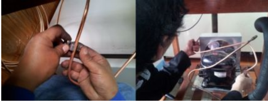
Figura 3.47: Corte del tubo para conexión entre el compresor y el condensador
