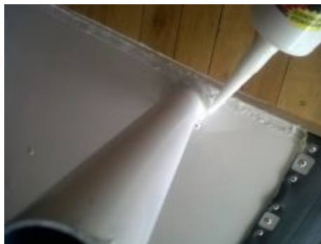
Figura 3.90: Aplicación de silicona entre los tubos y el perfil
