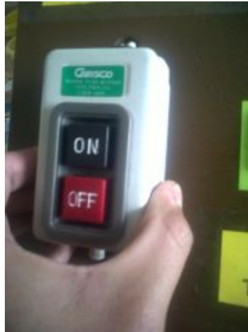
Figura 3.95: Colocación de pulsador
