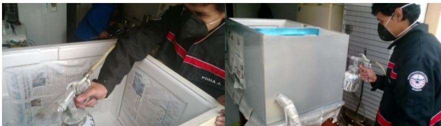
Figura 3.71: Pintado de la cámara (parte interna y externa)
