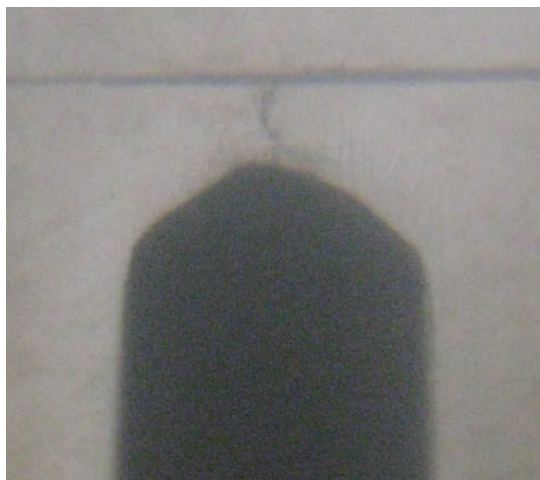
Figura 4.11 Grieta por fatiga
