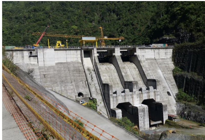
Presa de hormigón a gravedad Toachi
