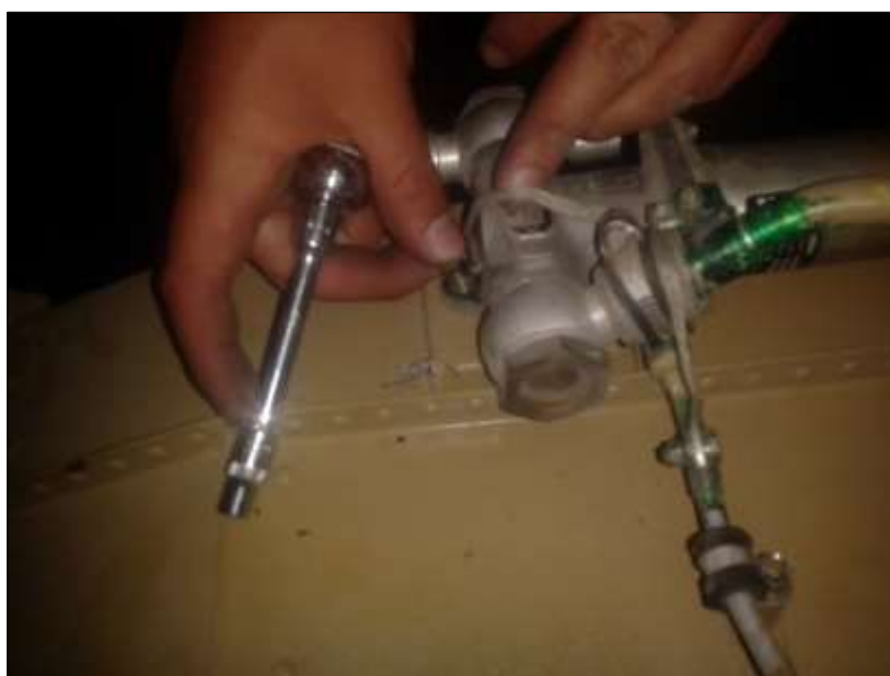
Figura 3. 14 Reinstalación de la bomba de transferencia con P/N 2180-F
