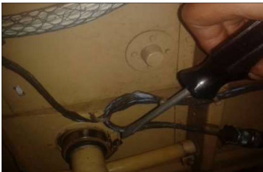
Figura 3. 18 Colocación de racores y abrazaderas de sujeción de las cañerías.
