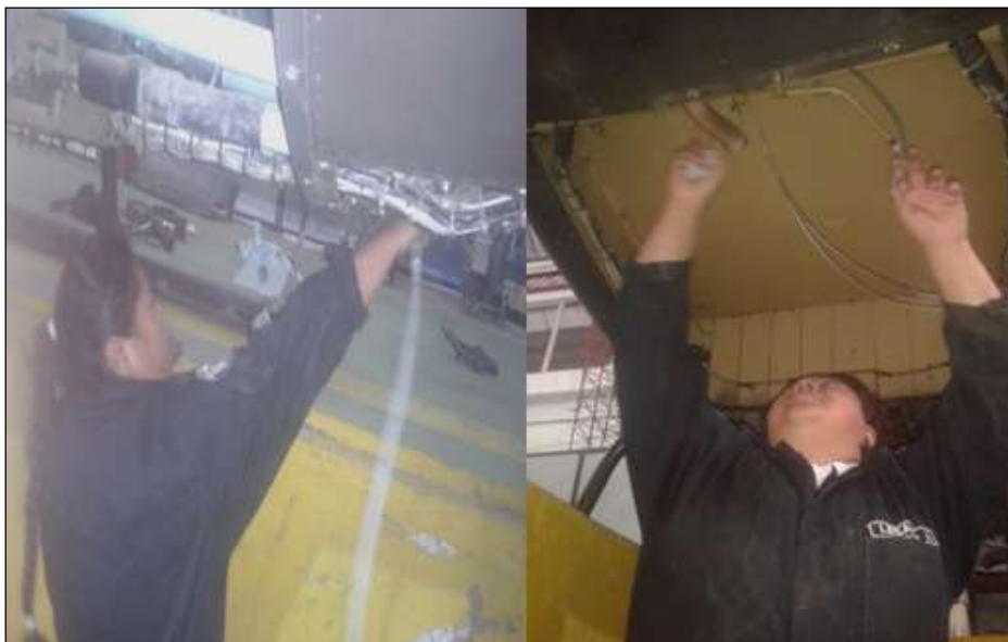
Figura 3. 9 Limpieza de la parte central inferior de la base del soporte del tanque auxiliar de combustible.
