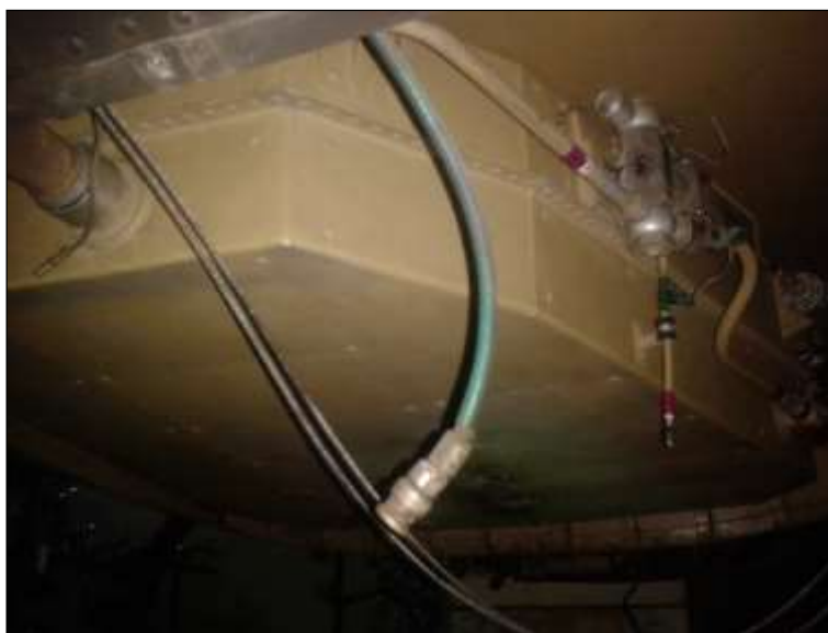
Figura 3. 26 Rehabilitación del sistema auxiliar de combustible principal
