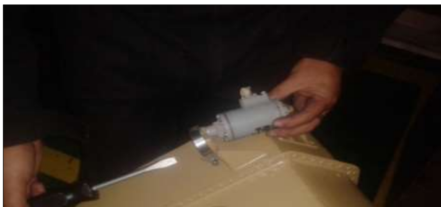
Figura 3. 13 Instalación del Mano-contactador Diferencial
