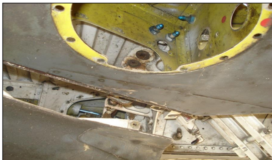
Figura 3. 8. Daños por corrosión
