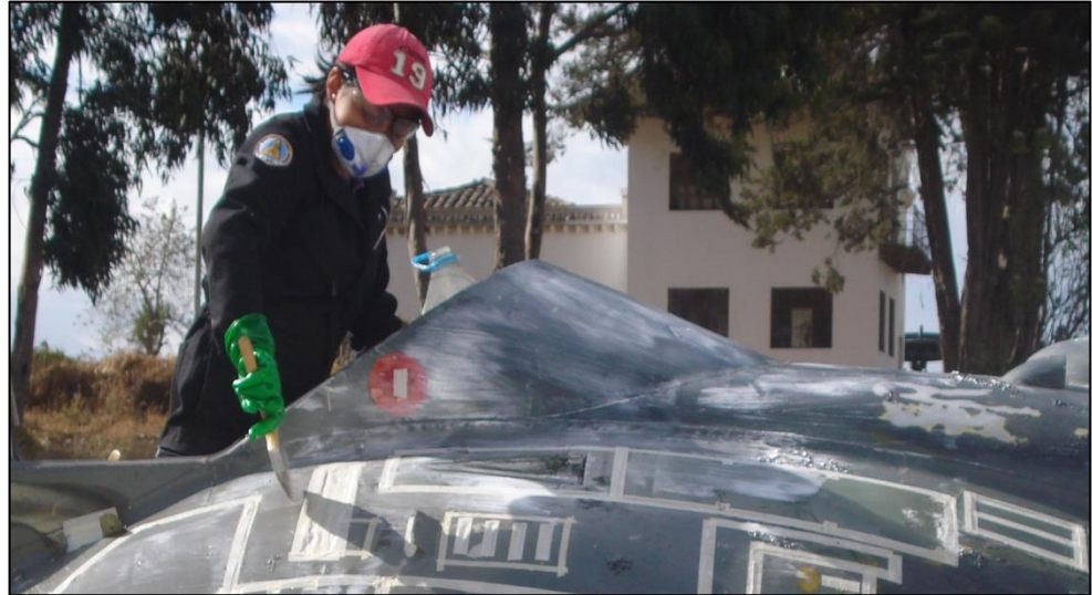
Figura 3. 17. Aplicación de removedor de pintura
