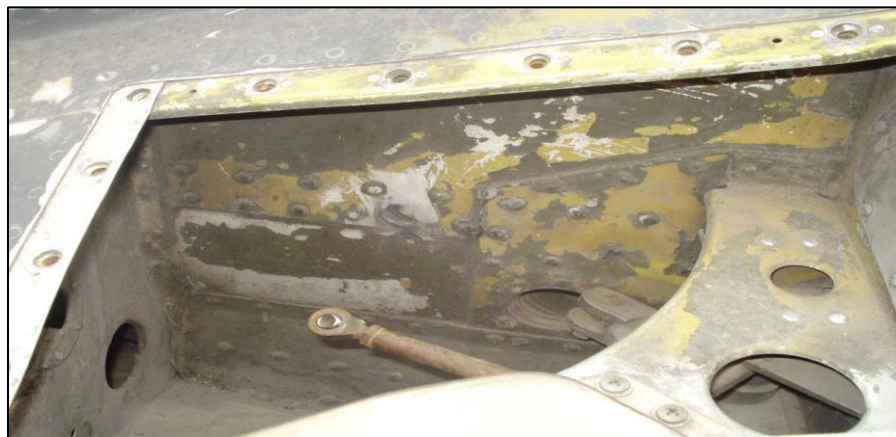
Figura 3.3. Tapas de inspección dañada
