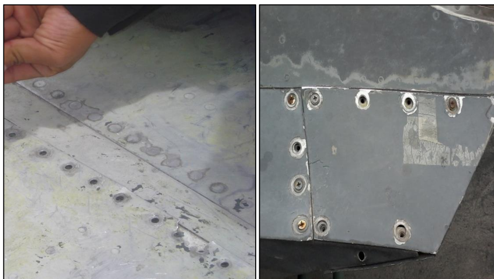
Figura 3. 5. Remaches salidos y tornillos defectuosos
