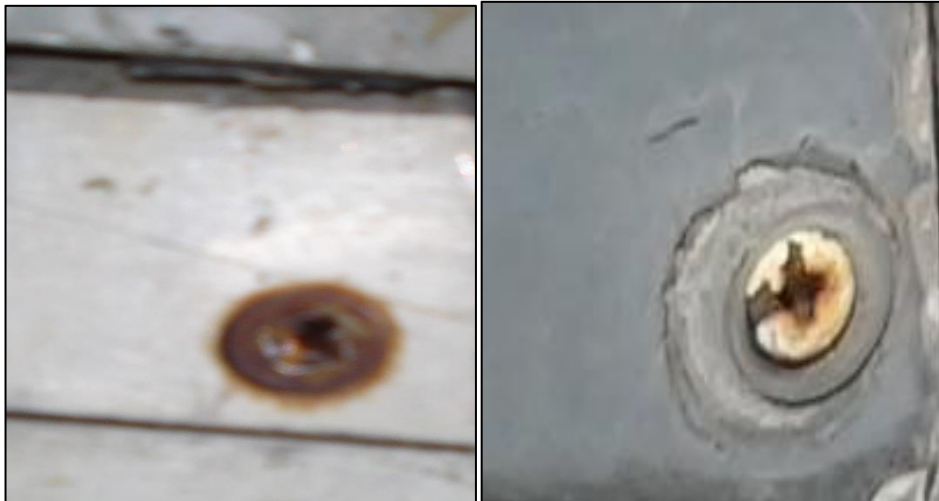
Figura 3. 9. Sujetadores corroídos
