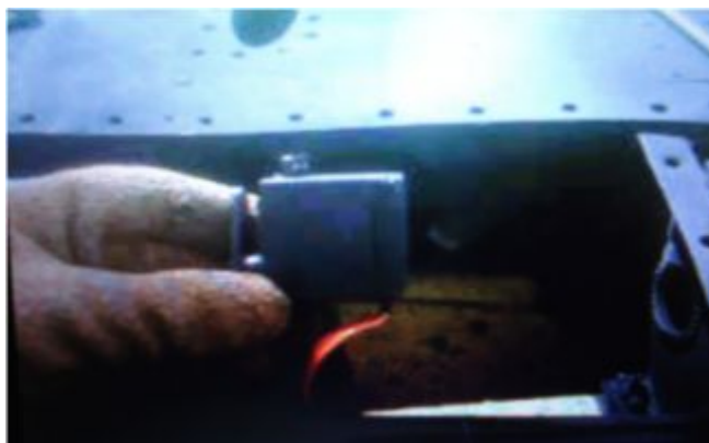
Figura 42: Instalación del servo actuador del TAB TRIM alerón.
