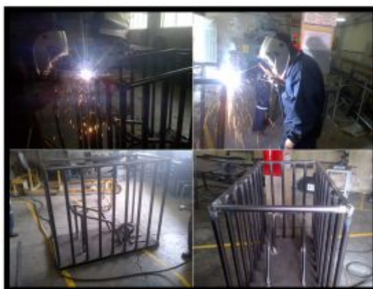
Figura 35. Soldadura de tubos en marcos
