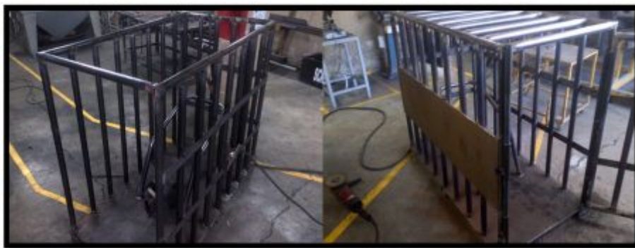
Figura 36. Soldadura de platinas y placa seguridad
