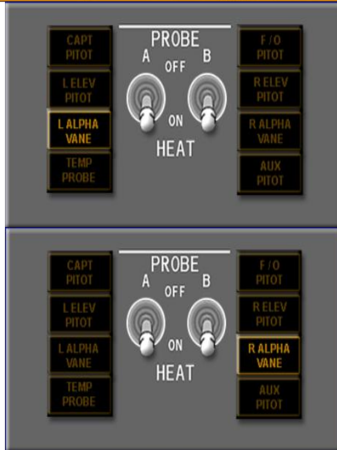
Figura 2.37 Operación de los Interruptores de Calentamiento de los Tubos PITOT.
