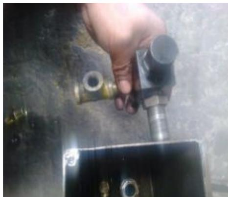
Figura 69. Instalación de la válvula.
