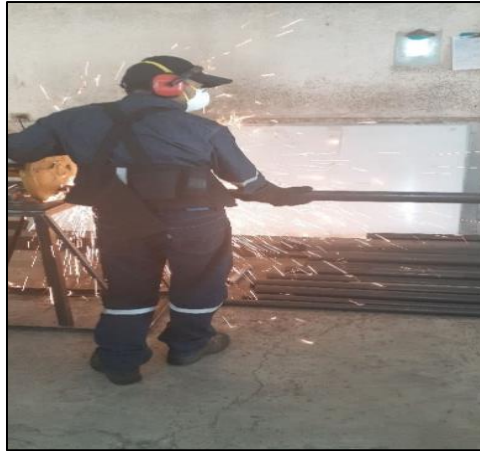
Figura 32. Cortes de los tubos.
