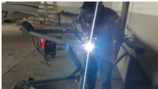
Figura 36. Soldadura del soporte móvil.
