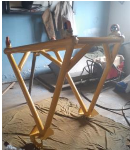
Figura 39. Aplicación de pintura.
