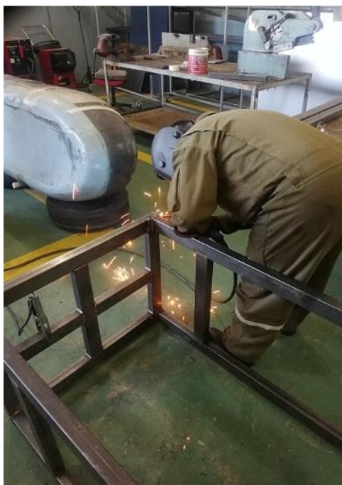
Figura. 31 Rectificados de la suelda
