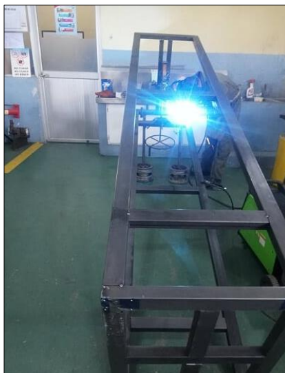
Figura. 29 Ensamble de la estructura
