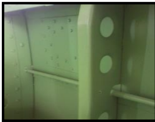
Fig. 2.4 Formadores de fuselaje
