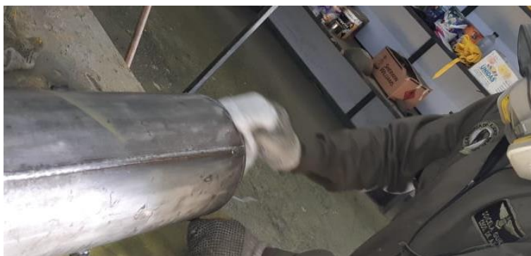
Figura 28. Lavado y limpieza de tanques
