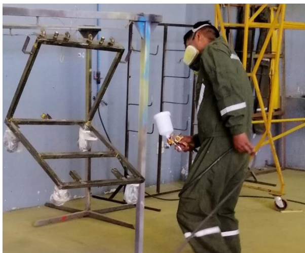
Figura 38. Aplicación del primer.
