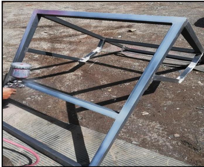
**Figura 29.** Colocación de Primer a la Estructura
