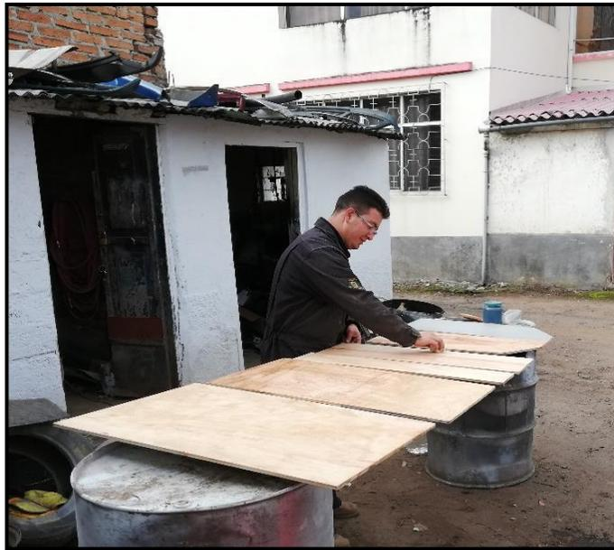
**Figura 32.** Proceso de Sellado de los Paneles
