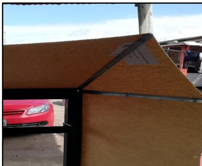
**Figura 28.** Instalación de ángulos de aluminio
