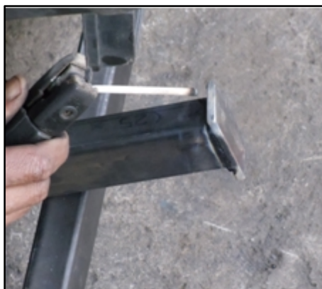
Fig. 3.28. Colocación de tapas Fuente: Sr. Coello Tapia Luis Angel
