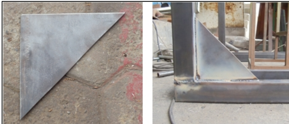
Fig. 3.20. Cartelas de la estructura base Fuente: Sr. Coello Tapia Luis Angel
