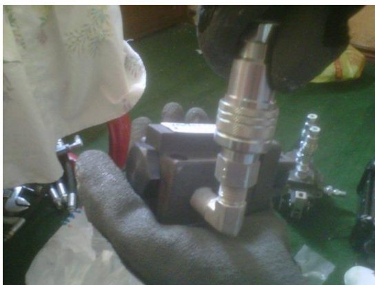
Figura 31. Instalación de los acoples rápidos.
