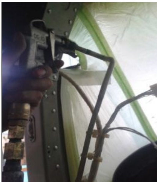
Figura 33. Limpieza interna de cañerías.
