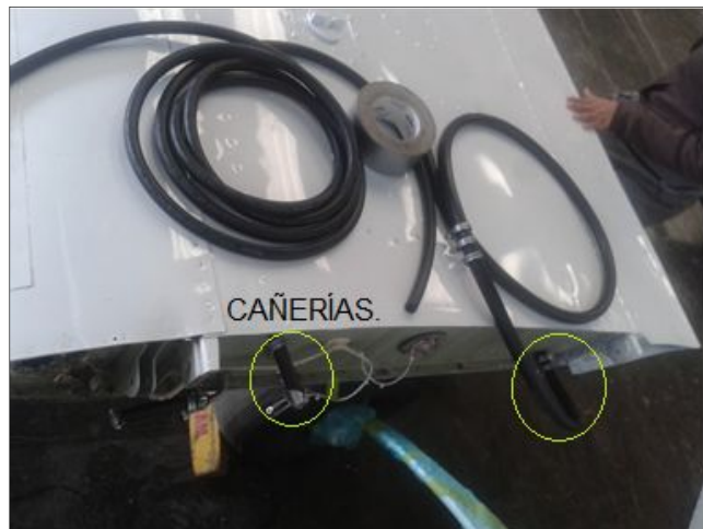
Figura 61. Conexión de cañerías del tanque al resto del sistema.
