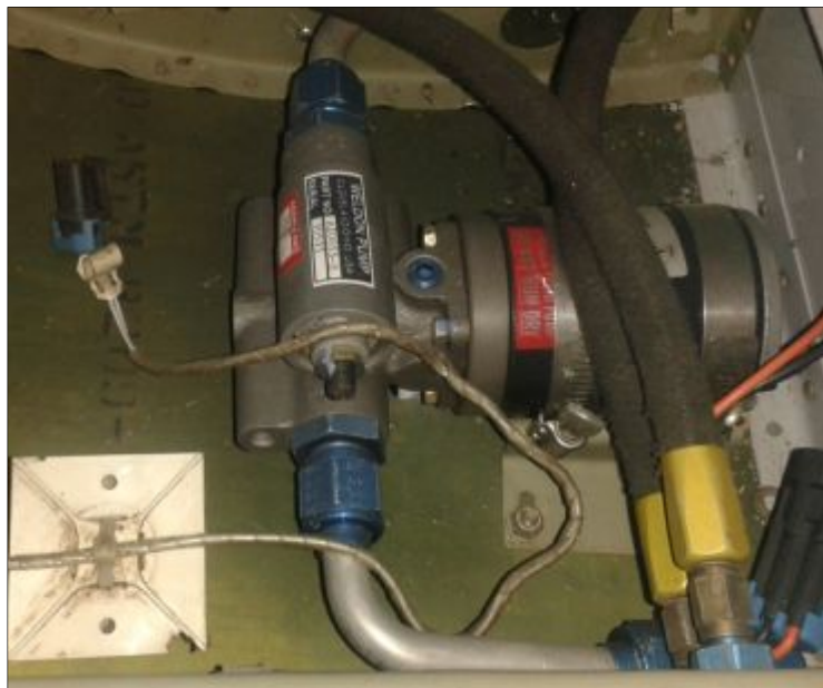
Figura 30. Limpieza de la bomba eléctrica.
