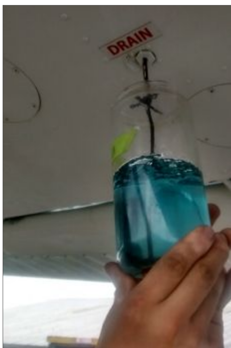
Figura 67. Verificación del funcionamiento de las válvulas de drenaje.
