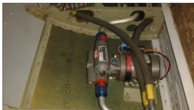
Figura 65. Instalación de la bomba eléctrica auxiliar de combustible.
