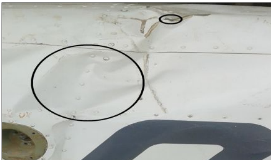
Figura 34. Presencia de correjimient laminar y rajaduras.
