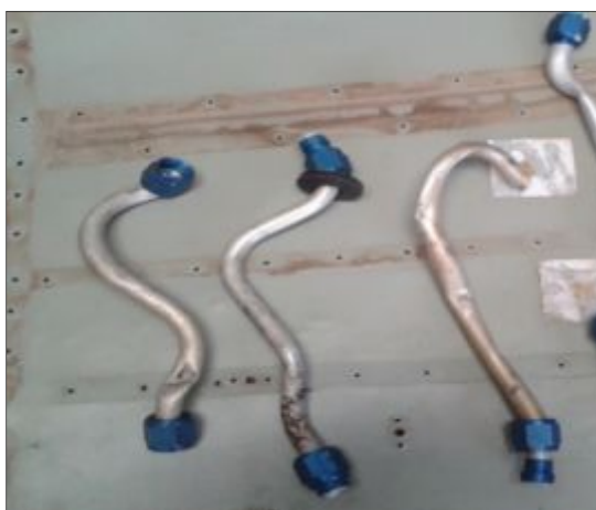
Figura 32. Estado de las cañerías.
