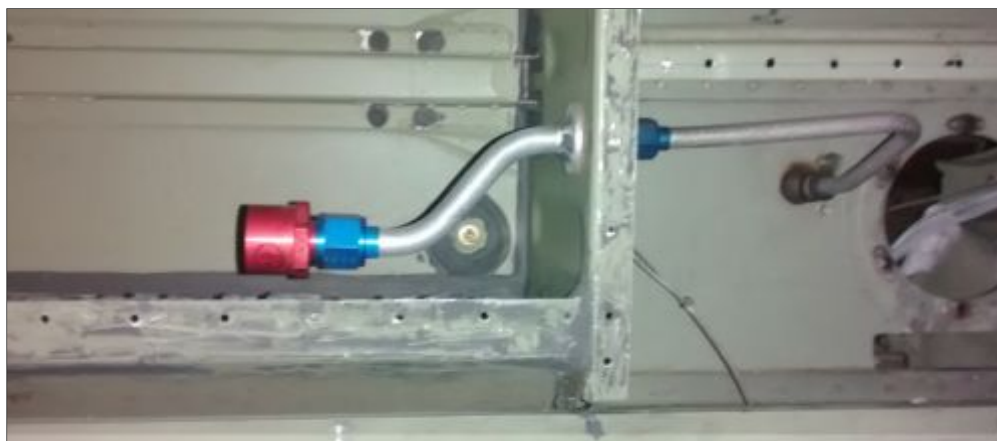
Figura 57. Sistema de ventilación de los tanques de combustible.
