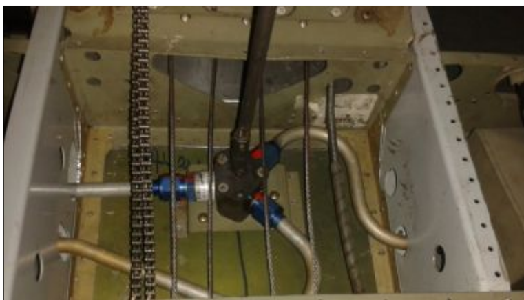
Figura 63. Instalación de líneas de combustible de la válvula selector.
