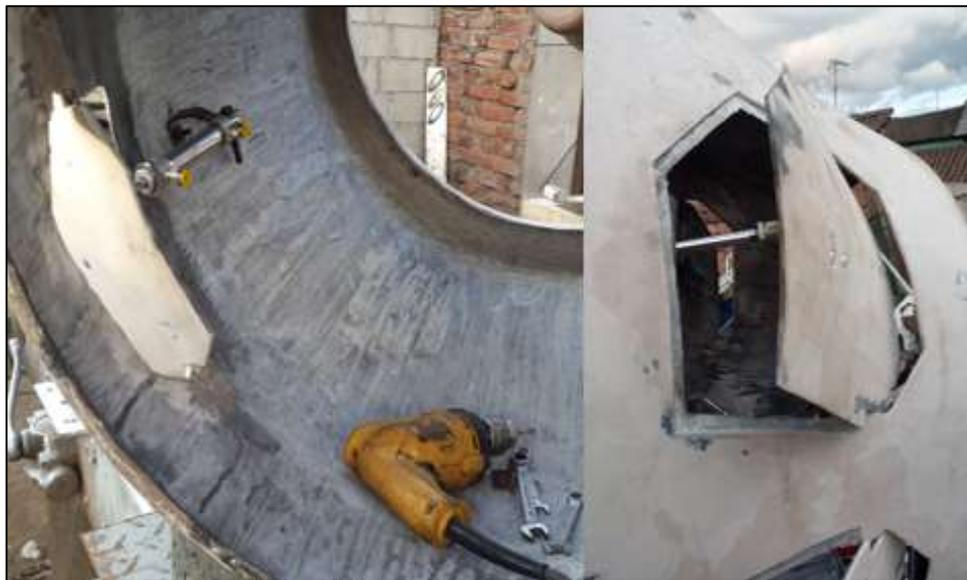
**Figura 26.** Construcción de soportes e instalación de los cilindros neumáticos
