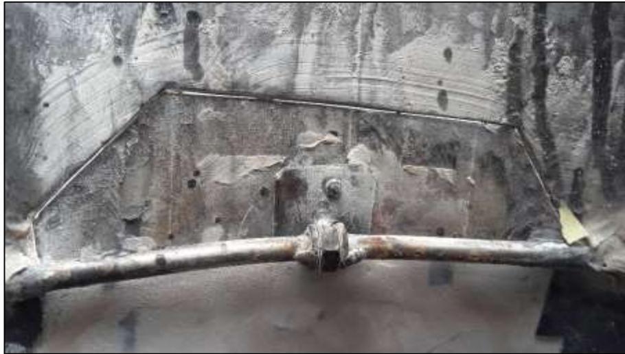
**Figura 24.** Sistema de apertura con la varilla y la placa
