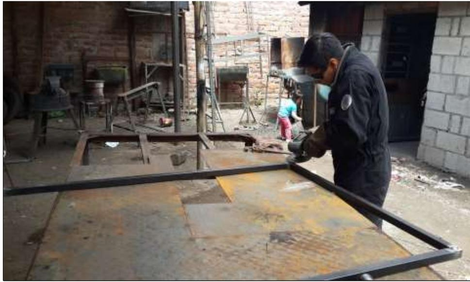
**Figura 34.** Esmerilando partes soldadas
