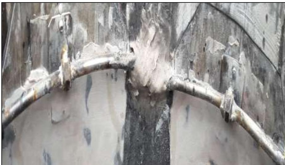
**Figura 25.** Fibra y masillado en las compuertas
