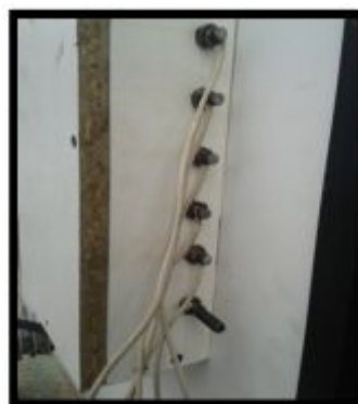
Figura. 69 Conexiones a masa
