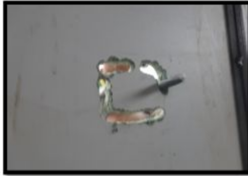
Figura. 72 Orificio para instalar el regulador de voltaje
