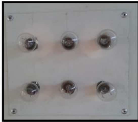
Figura. 76 Instalación de luces de carga
