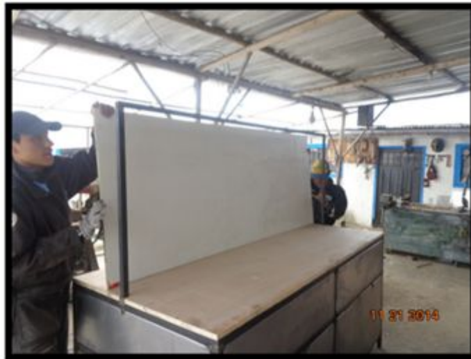
Figura. 55 Sujeción de las planchas a la estructura
