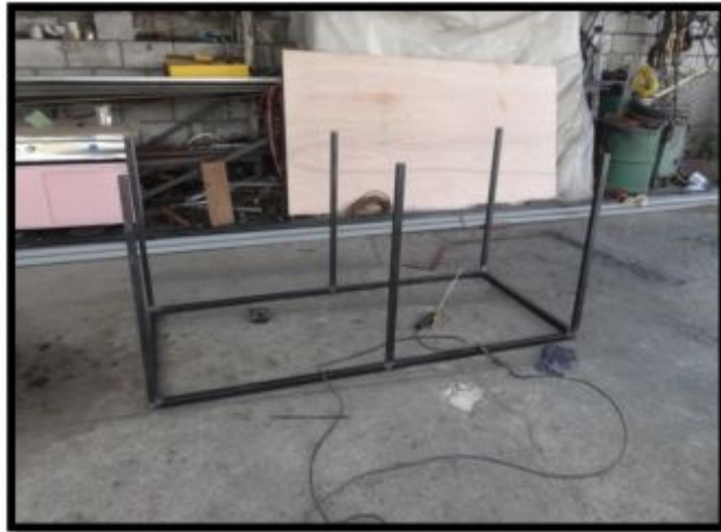
Figura. 48 Banco de prueba en proceso de soldadura
