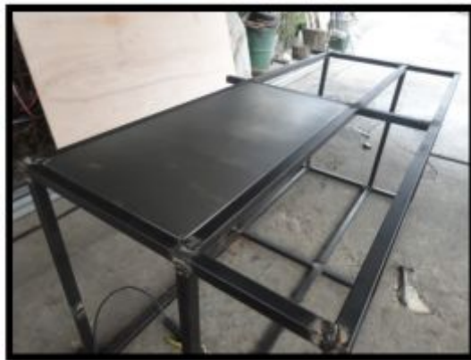
Figura. 53 Recubrimiento de la estructura
