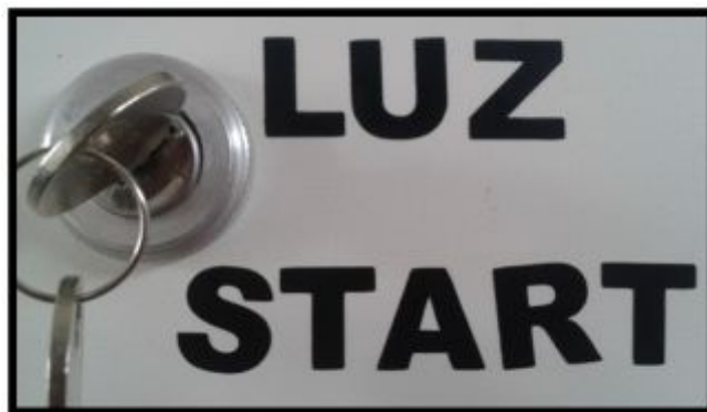
Figura. 73 Instalación del Switch de arranque
