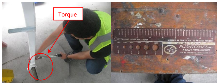
Figura 65. Montaje del eje del soporte del tren principal, cessna 182.
