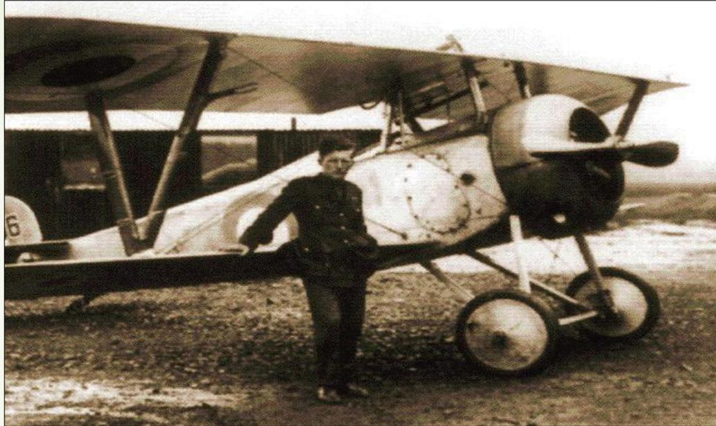
Con la primera Guerra Mundial aparece el primer tren de aterrizaje. Era una estructura fija atornillada al fuselaje en forma de “V” con una rueda en su vértice.
