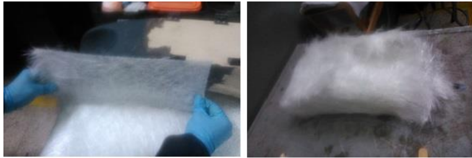
Figura 21: Medición y recubrimiento con la fibra de vidrio
