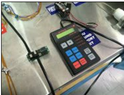
Figura 71. GSU y tablero LED I/O conectados.
