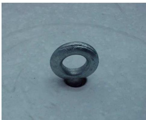
**Figura 3.19:** Hoisting eye colocado en punto de izaje.
