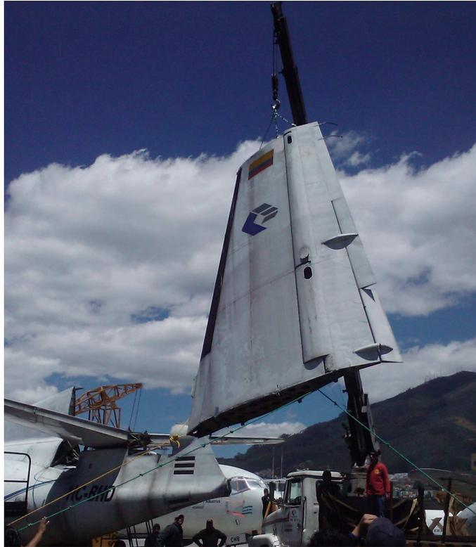
**Figura 3.29:** Izamiento del Estabilizador Vertical
