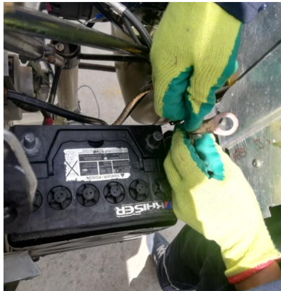
Figura 29 Alimentación eléctrica al motor desconectada
