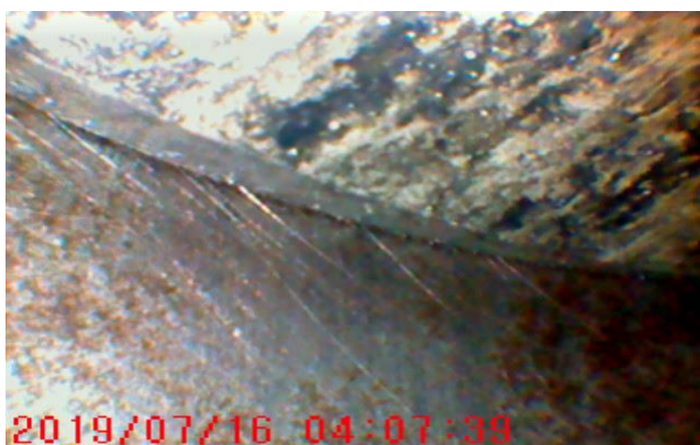
Figura 41 Superficie interna del cilindro No 1
