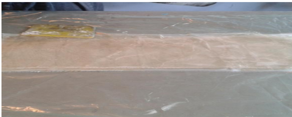
Figura 3.22. Aplicación de las telas auxiliares
