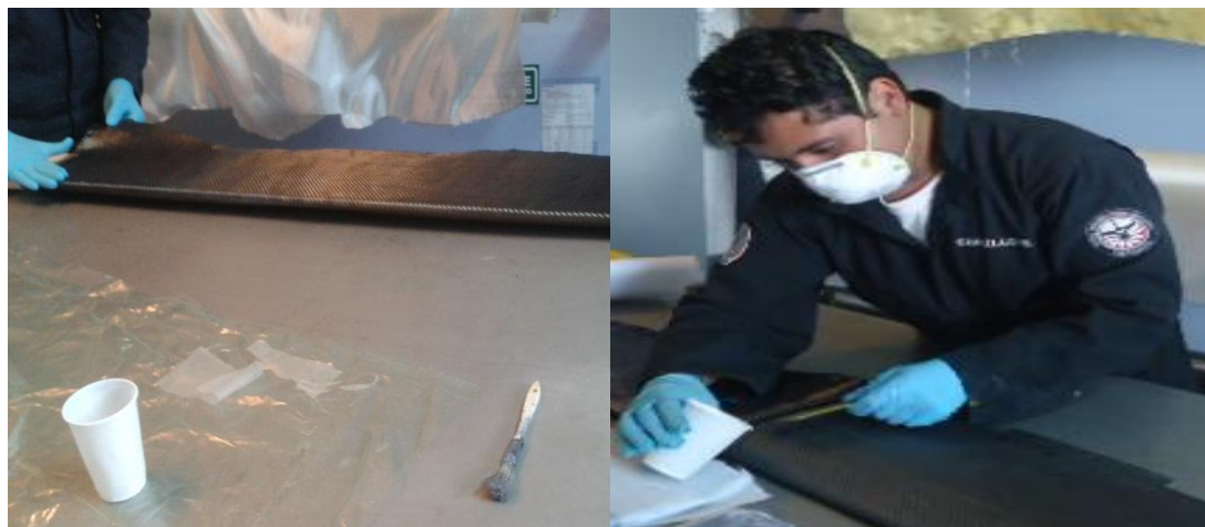
Figuras 3.20. Unión del ala con la fibra de carbono
