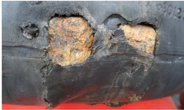
Figura 2.19. Corrosión a temperaturas elevadas
