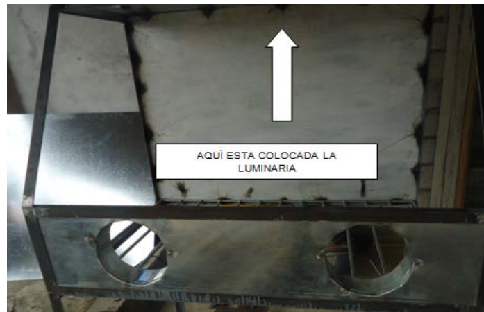
Figura 3.22. Instalación de la luminaria
