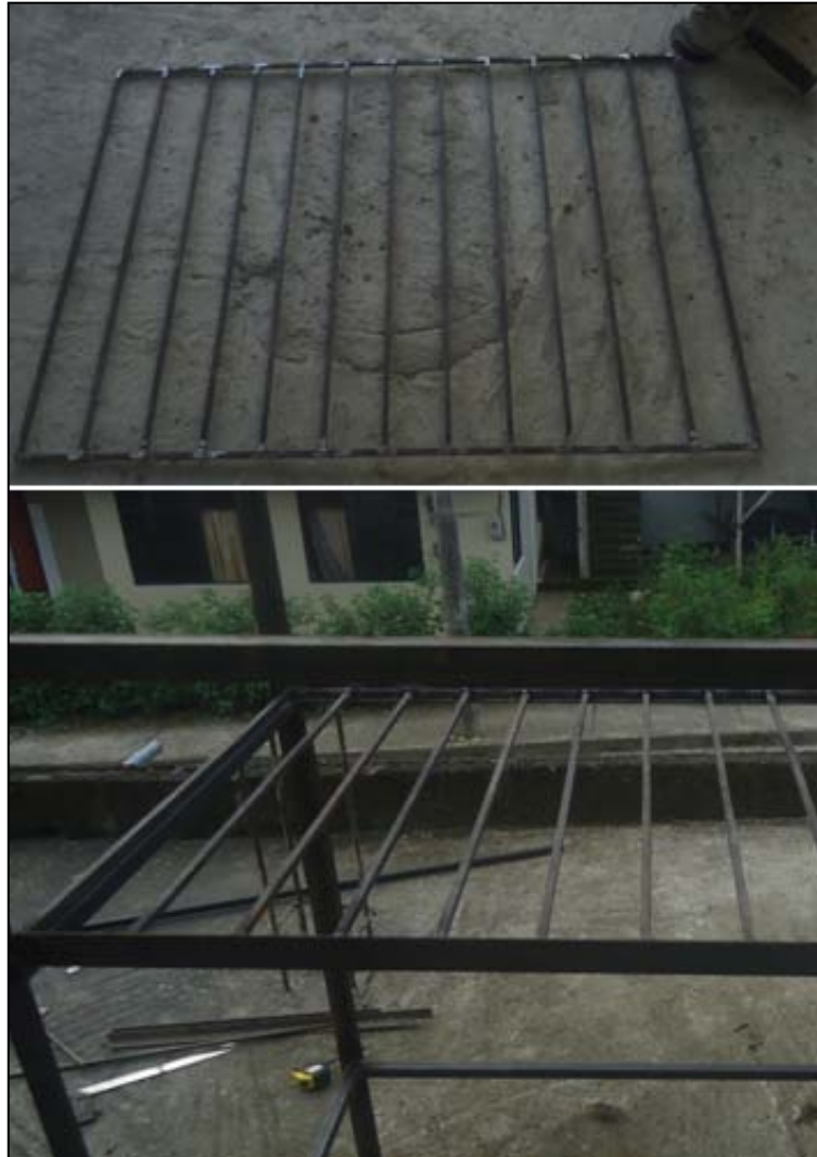
Figura 3.15. Construcción de la rejilla
