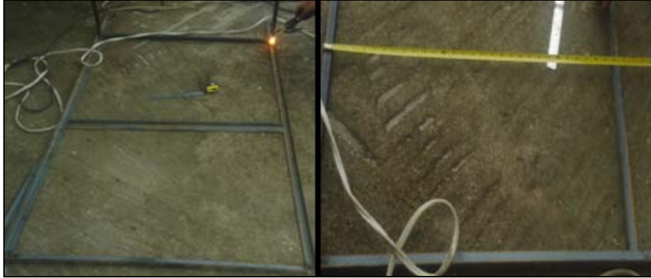
Figura 3.14. Soldadura y comprobación de medidas
