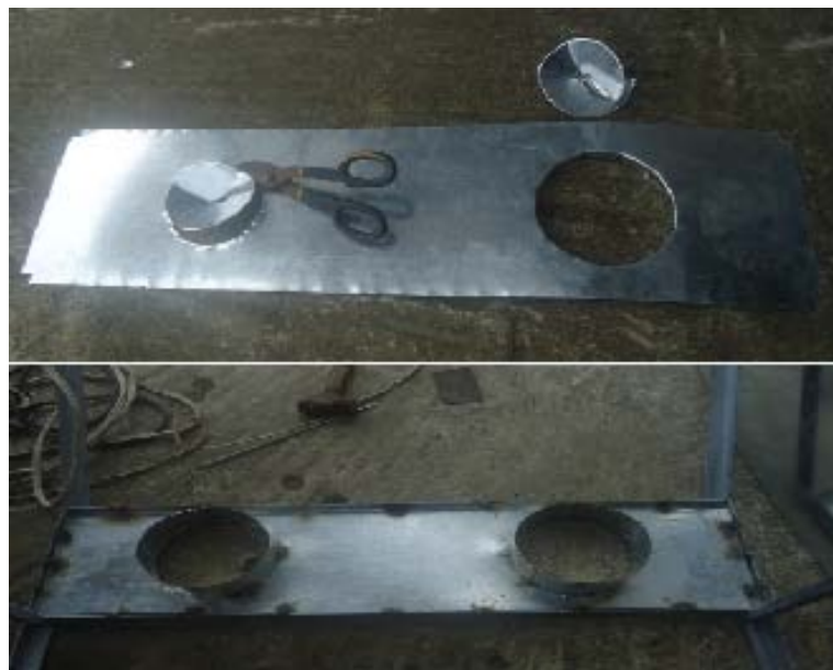
Figura 3.17. Construcción del portamangas
