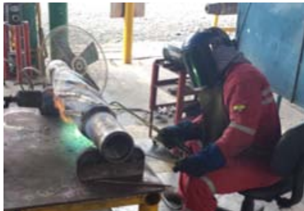
Figura 2.24 Operación de soldadura
