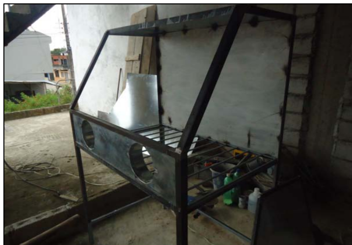
Figura 3.1 Estructura cabina sandblasting
