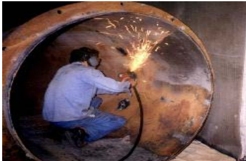
Figura 2.20. Limpieza superficial de la corrosión
