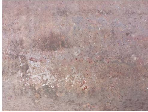
Figura 2.11. Grado de herrumbre D
