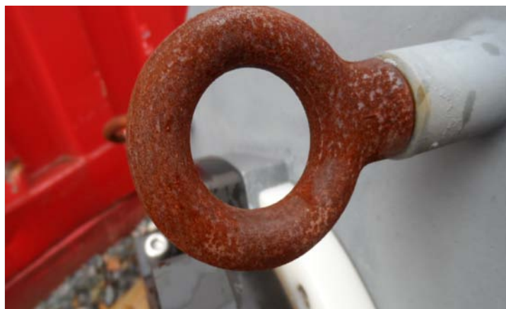
Figura 2.16. Formas de corrosión selectiva
