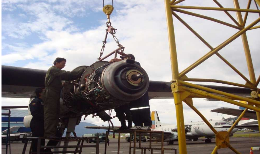
Figura 3.18: Colocación de la eslinga al motor
