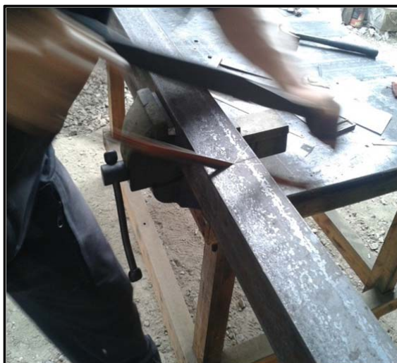
Figura 3.16: Corte del material
