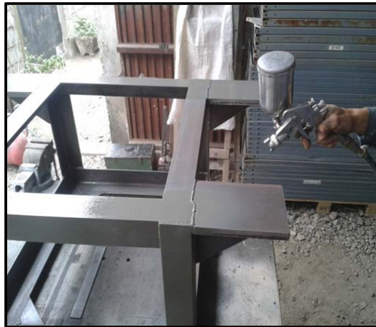
Figura 3.29: Primera capa de pintura a la estructura del montante
