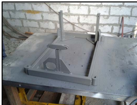
Figura 3.39: Primera capa de pintura a la segunda parte del montante
