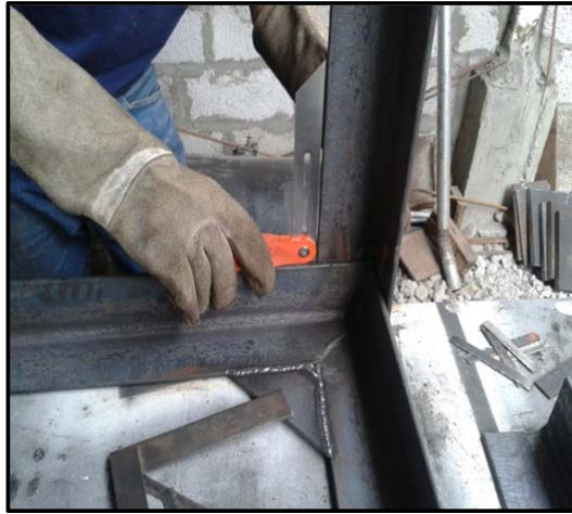
Figura 3.21: Columnas del montante
