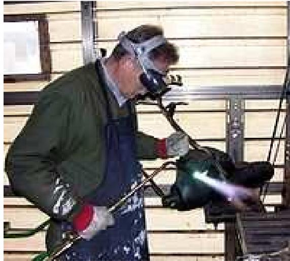
**Figura 2.35** Soldadura a gas de una armadura de acero
