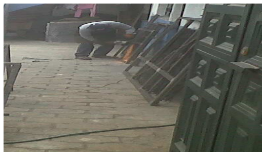
Figura 3.4. Elaboración de la caja para el modulo de presión
