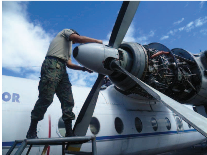
Figura 3.25 Remoción del Spinner. Fuente: Investigación de campo.
