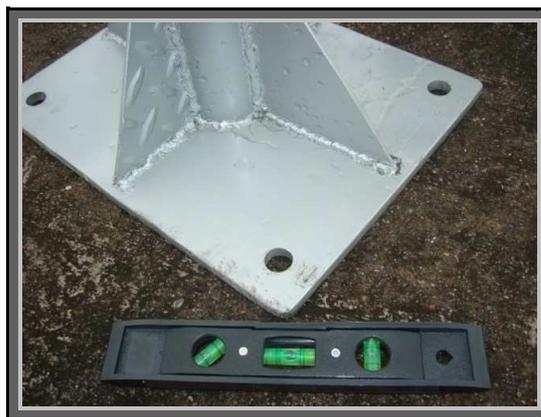
Foto 3.12 Nivelación de los puntos de anclaje
