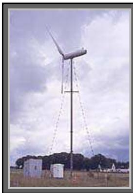
Figura 2.14.3 Torres mástil tensados con vientos
