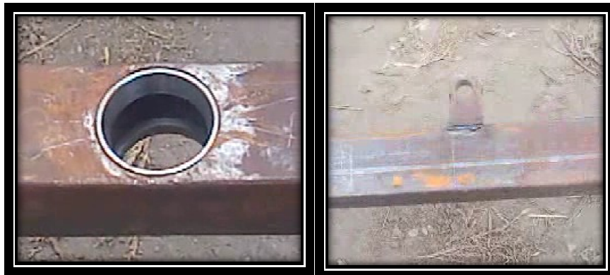
Figura 3.39. & 3.40. Suelda implementada en sujeción de elementos principales
