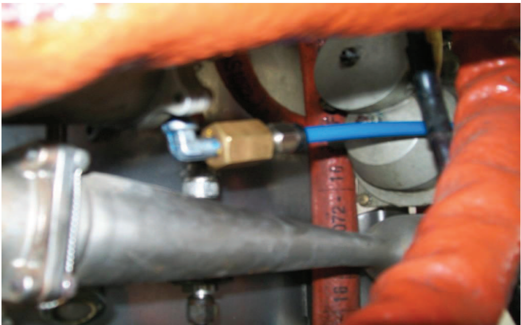
Figura 2.C Acoplamiento a la entrada de aire de la válvula shut off Fuente: Investigación de campo
