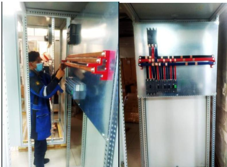
*Nota.* En la figura 17 se muestra la instalación de las barras de cobre con los respectivos aisladores tipo escalera e identificación de las líneas eléctricas por colores.
