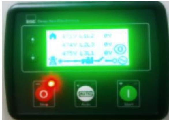
*Nota.* En la figura 9 se muestra en módulo DSE 4520 para la identificación de fallas eléctricas en la red.
