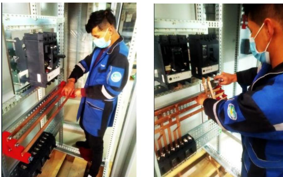
*Nota.* En la figura 7 se muestra las instalaciones de las barras de cobre para la conducción de la energía eléctrica y alimentación de los diferentes dispositivos que lo componen.
