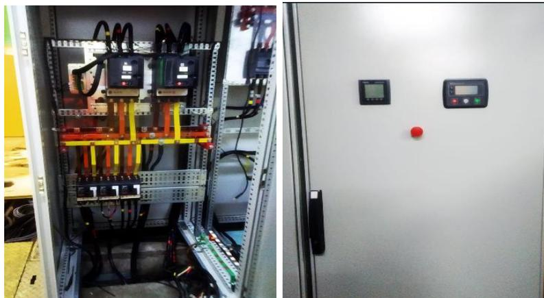
*Nota.* En la figura 23 se muestra las conexiones eléctricas de alimentación para la puesta en funcionamiento del armario eléctrico de 460 voltios.
