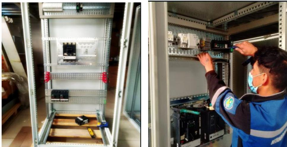
*Nota.* En la figura 6 se muestra las instalaciones de los breakers y de los relés eléctricos dentro del gabinete.
