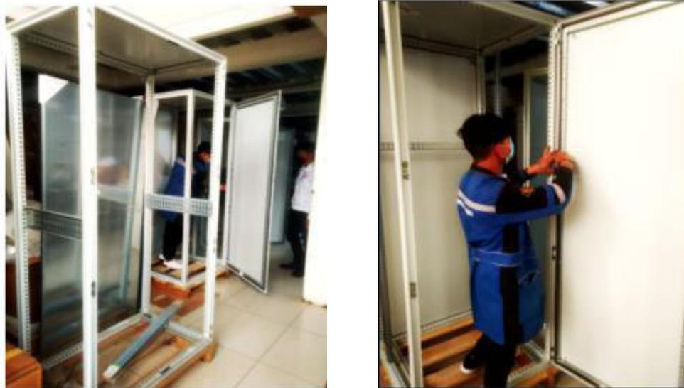
*Nota.* En las figuras 5 se muestran dos cuadros correspondientes a la estructura y armado de los armarios eléctricos, en la primera se presenta la estructura del armario y en la segunda se identifican las partes del mismo.
