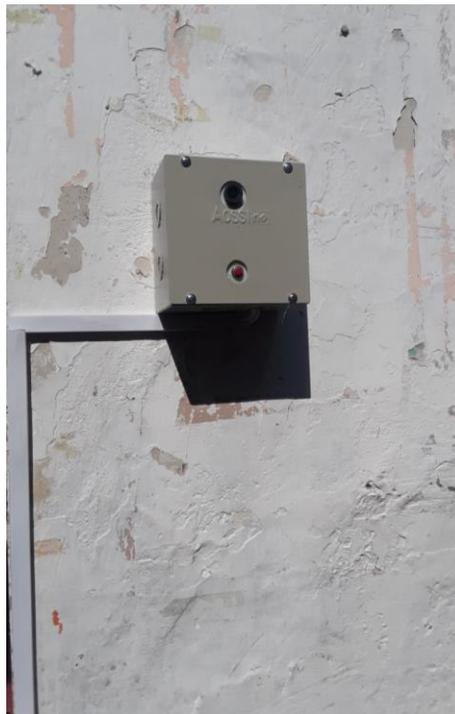
*Nota.* Finalmente, el video portero se le instaló una estructura metálica para que soportes ambientes de lluvia y no tener problemas a un futuro.
