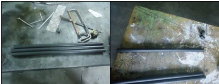
Figura 3.10. Proceso de construcción de la estructura base
