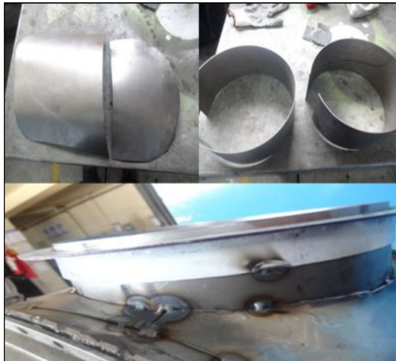
Figura 3.14 Construcción de los ductos
