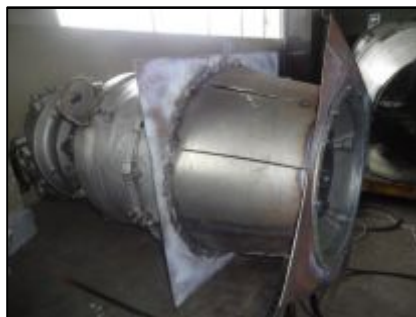
Figura 3.32 Test para acoplar el Case en el motor
