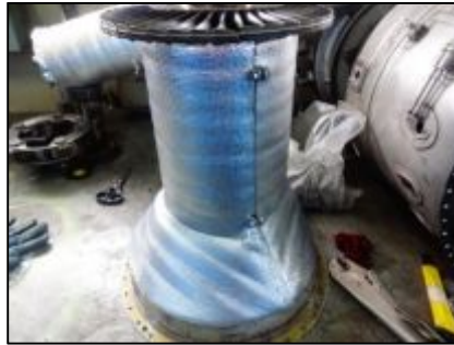
Figura 3.38 Insulation blanket instalada montada en el eje de la turbina
