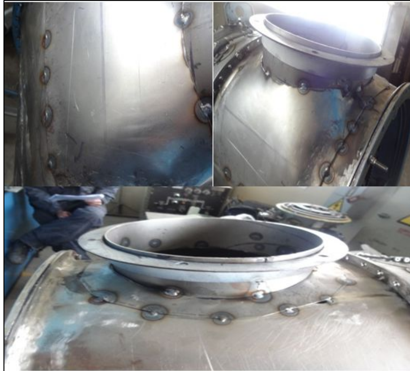
Figura 3.17 Ductos ensamblados en el case
