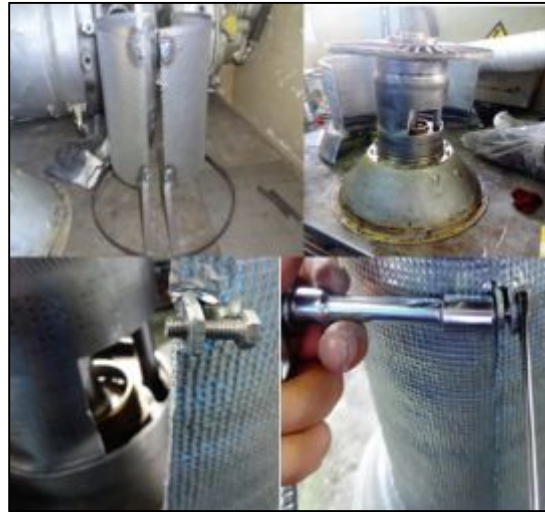
Figura 3.25 Instalación de la Insulation blanket
