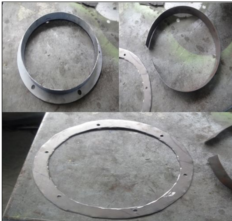
Figura 3.6 Construcción de los anillos del ducto
