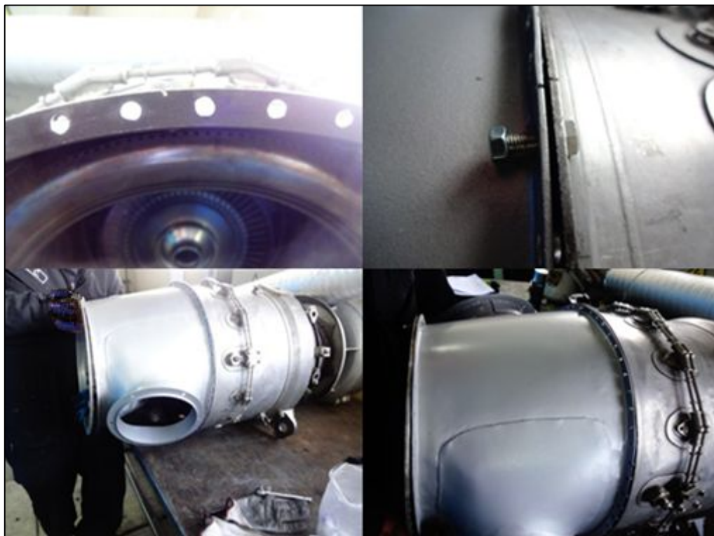
Figura 3.21 Instalación del Exhaust duct Case en el motor
