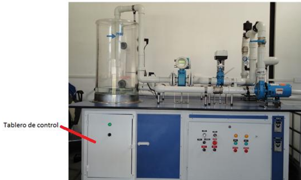
Figura 3.29: Vista frontal del tablero
