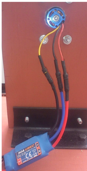
Foto 3. 4. Conexión entre los terminales del motor y del ESC
