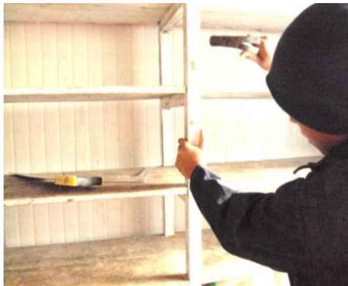
Figura N° 23 Estantería de madera siendo ubicada en el cuarto frío
