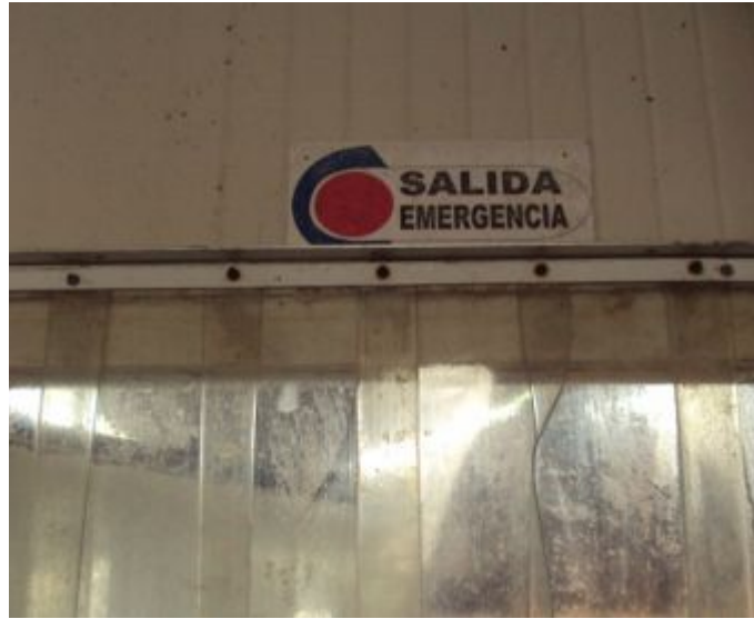
Figura N° 15 Rótulo de Salida de Emergencia en el cuarto frío
